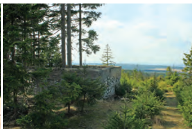
Praha - zbytky německé radarové ústředny
